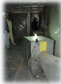
隔離養生区画内(除去作業前)
